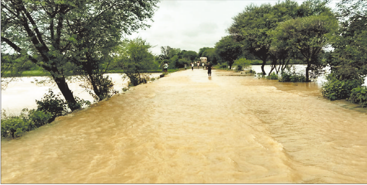
सड़क के ऊपर बह रहा पानी।
